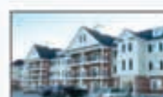
Hwy 401/Mill St
